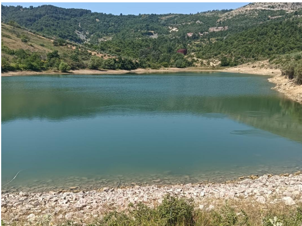
Fig.1. Pamje nga Diga e Rezervuarit të Mbolanit
