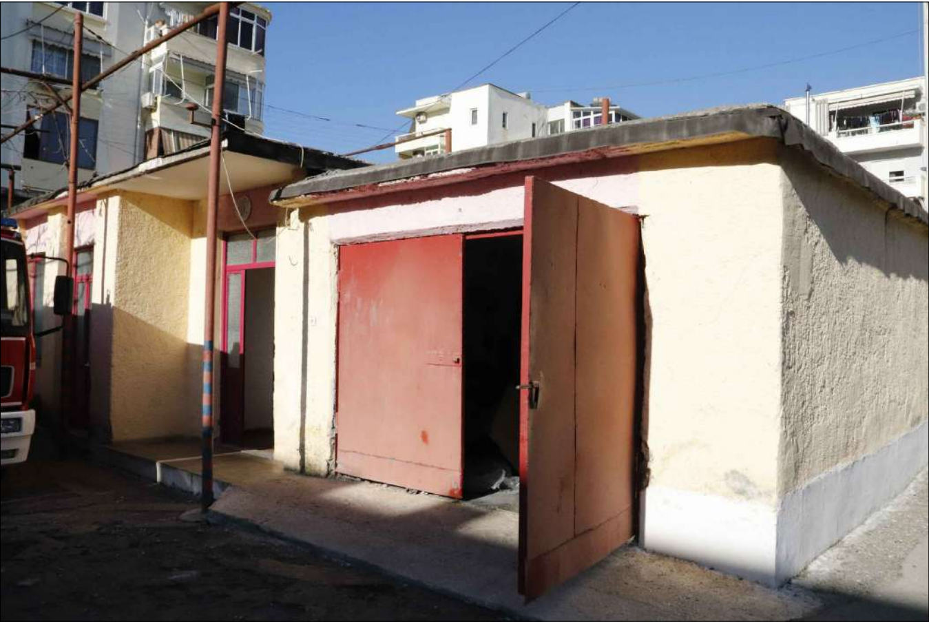
Foto te gjendjes ekzistuese
